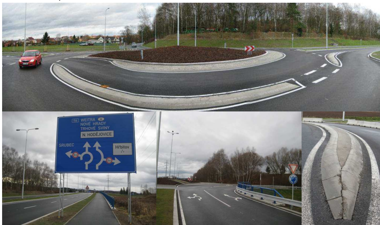
Obrázek 36: Okružní křižovatky s fyzicky oddělenými jízdními pruhy na okruhu a ukázkami značení v Českých Budějovicích.
