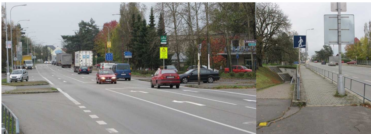
Obrázek 37: Pohled od K1 na K2 a přechod pro chodce.
