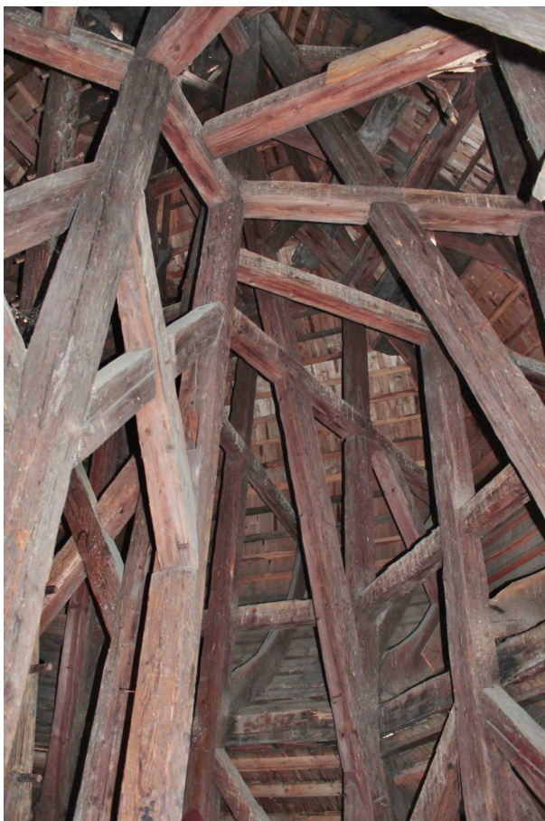
1. Pohled na část konstrukce krovu.
