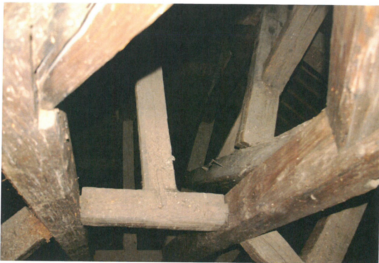
Obr. 33: Pohled na části osmibokých věnců středového sloupu v úrovni prvního a druhého hambalkového patra (Kudrnovský 2014).
