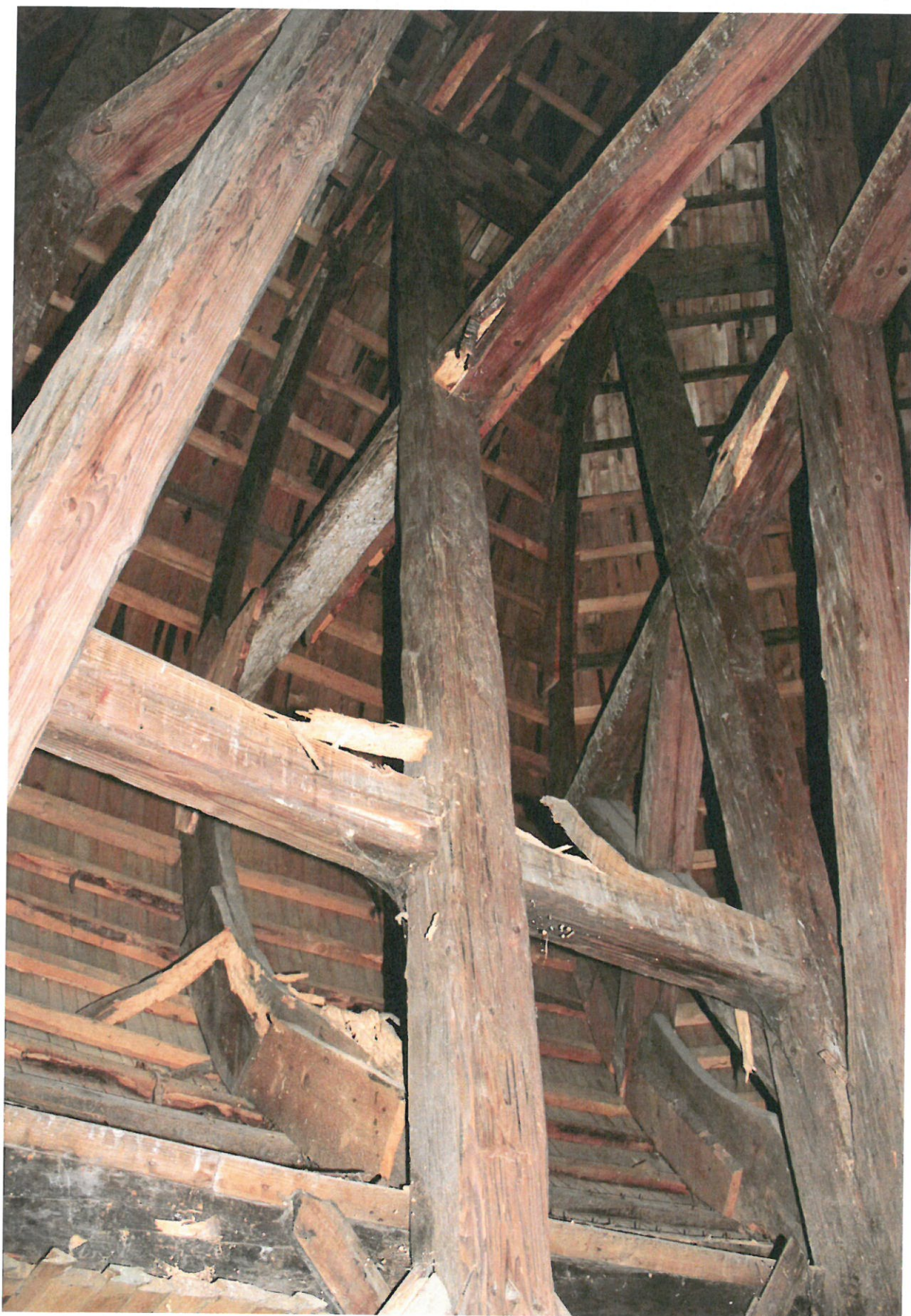
Obr. 32: Pohled na vnější sloupy vynášející v úrovni druhého hambalkového patra vaznice. Vnější sloupy, hambalky a ramenáty jsou v každé sudé vazbě rozepřeny ondřejskými kříži (Rohlíček 2014).
