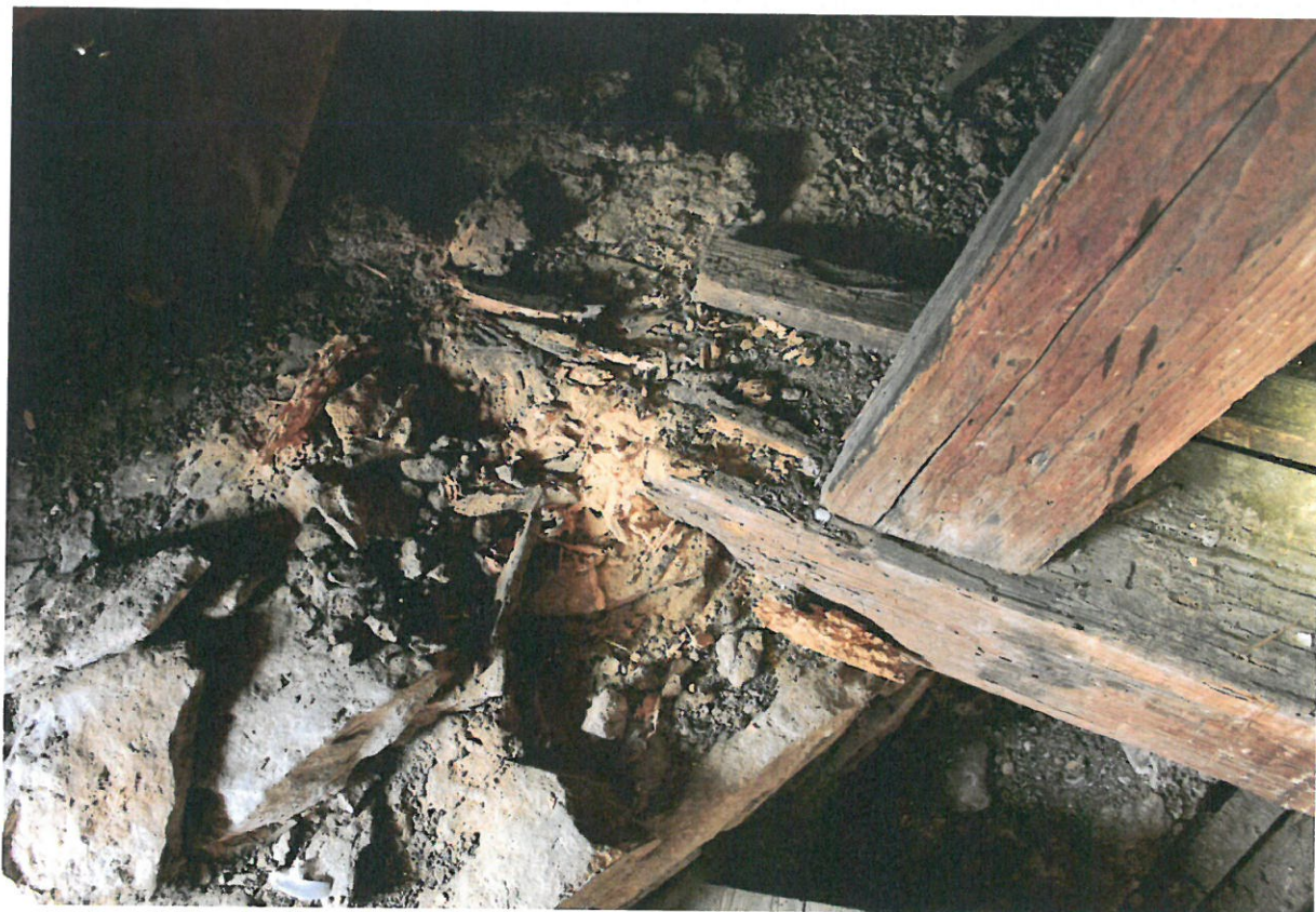
Obr. 28: Biotické napadení vazného trámu základového roštu výrazně narušující statickou funkci prvku (Rohlíček 2014).
