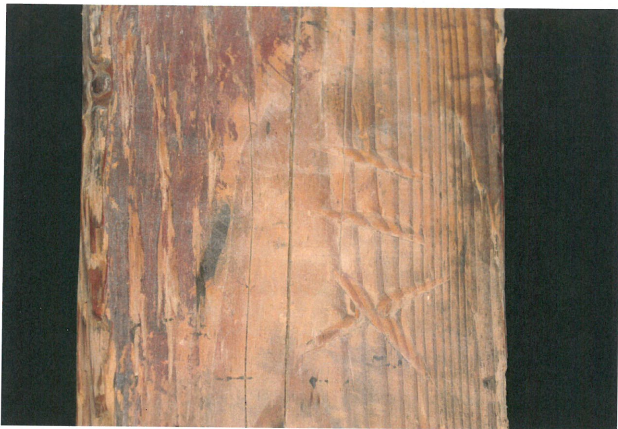
Obr. 22: Detailní pohled na tesařskou značku na sloupu štenýře (Kudrnovský 2014).
