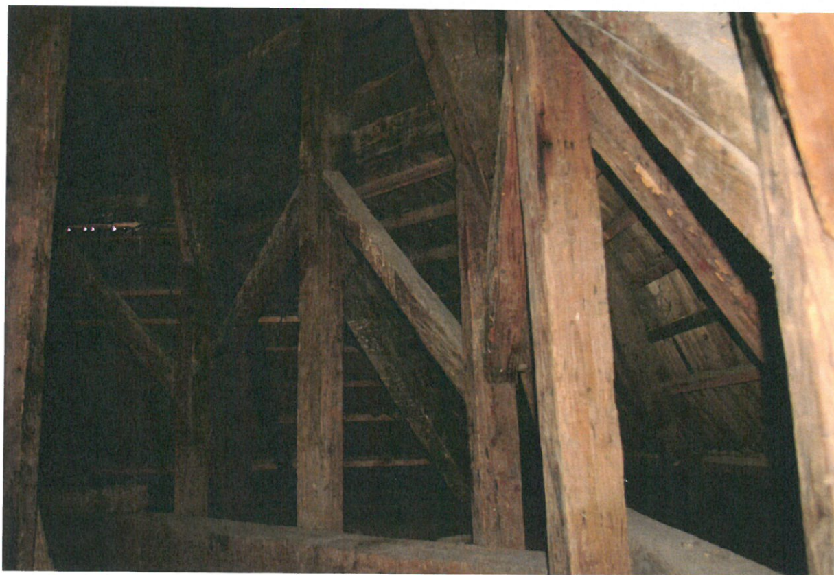
Obr. 31: Pohled na zavětrované vnější sloupy vynášející v úrovni druhého hambalkového patra vaznice (Kudrnovský 2014).
