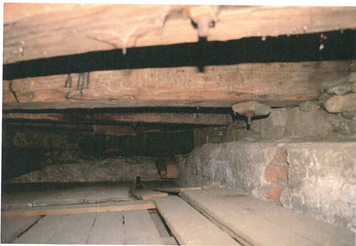
Obr. 17: Pohled do prostoru mezi stropním záklopem a základovým roštem (Kudrnovský 2014).
