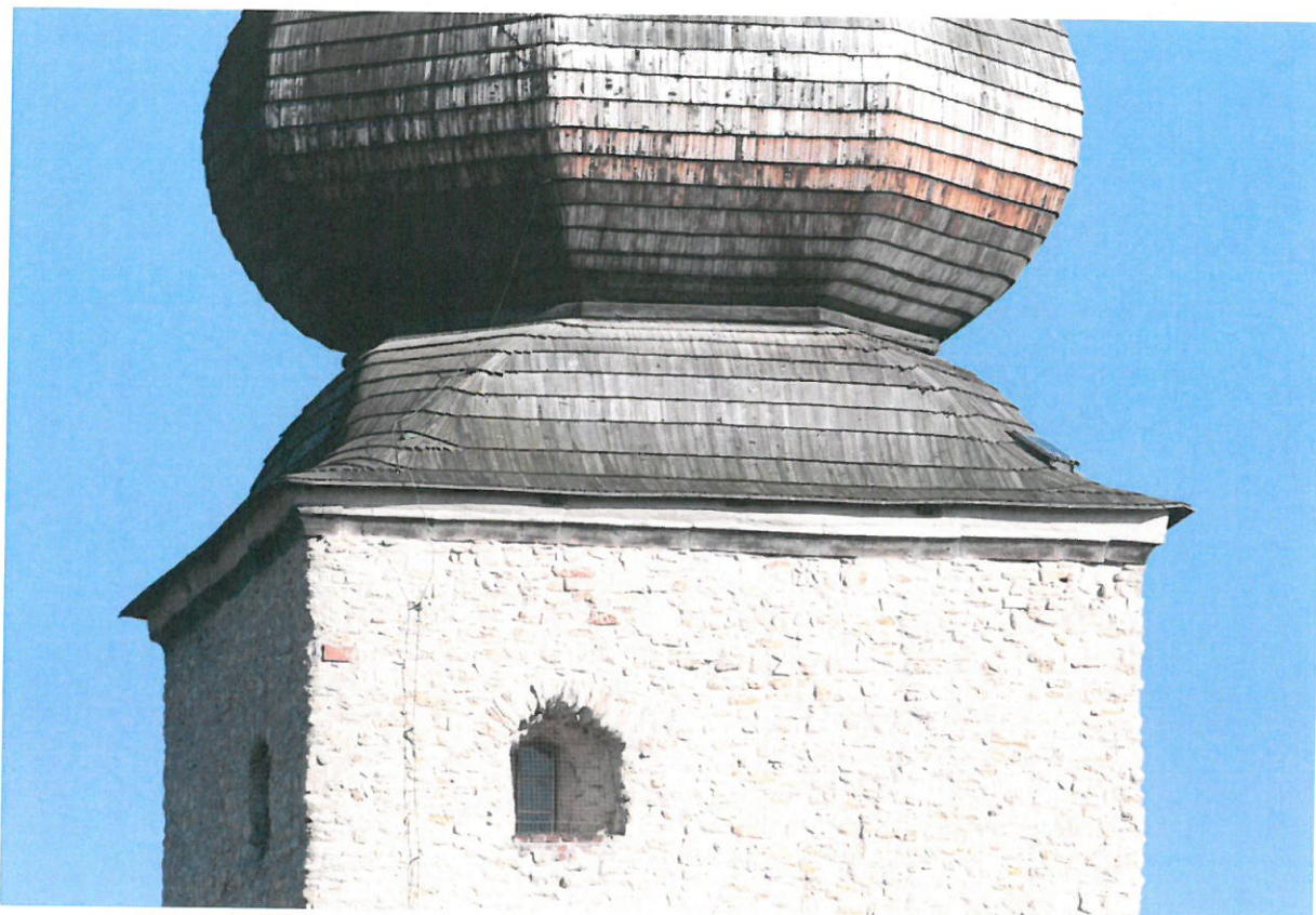
Obr. 10: Spodní část cibulové střechy s šindelovou krytinou (Rohlíček 2014).
