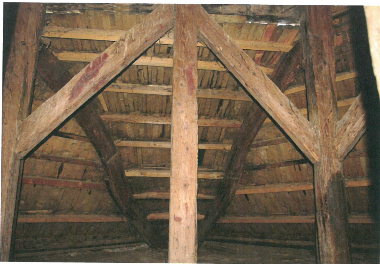
Obr. 30: Pohled na ramenáty a zavětrované vnější sloupy (Kudrnovský 2014).
