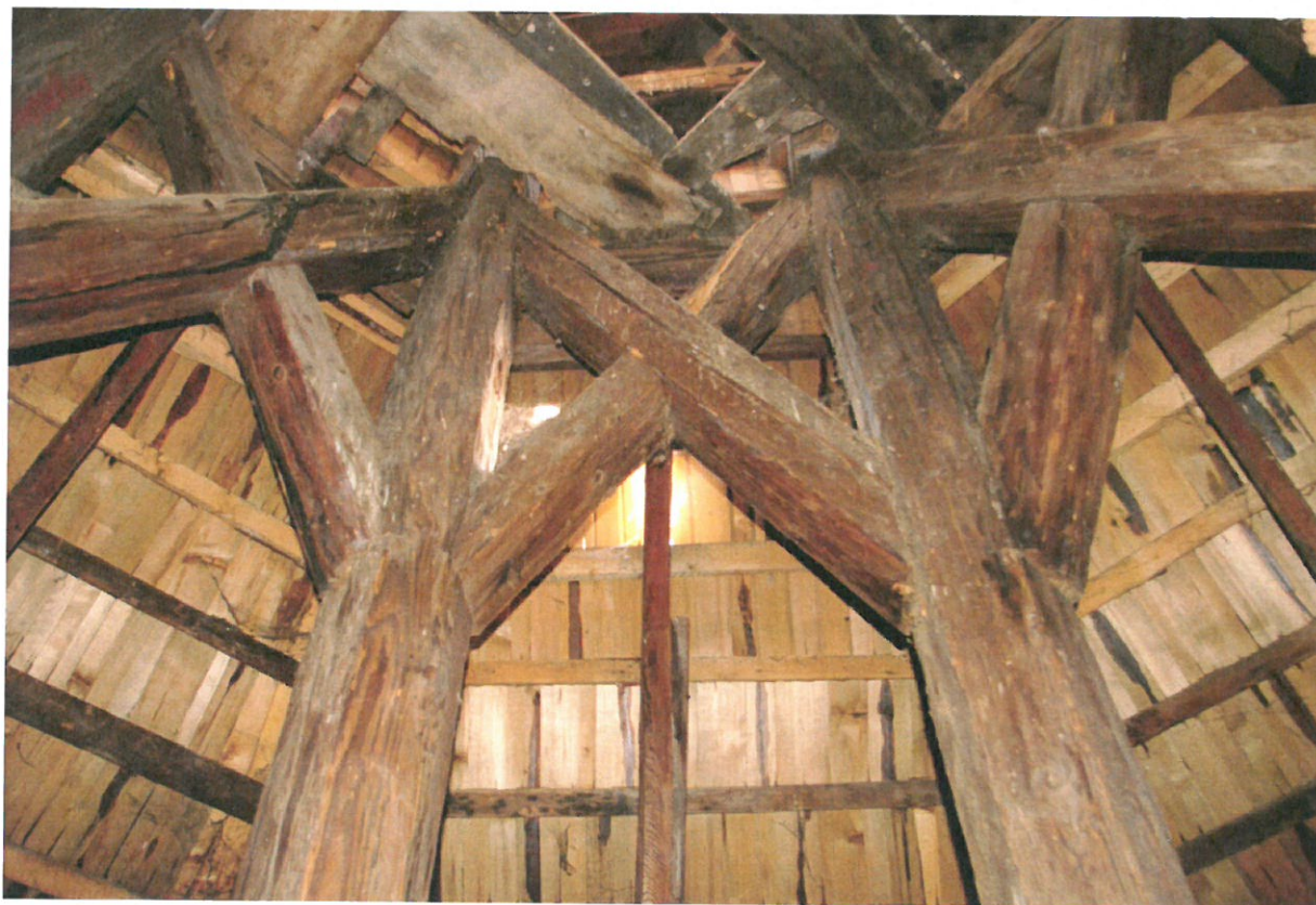
Obr. 36: Ondřejské kříže ztužující horní část středového sloupu (Kudrnovský 2014).
