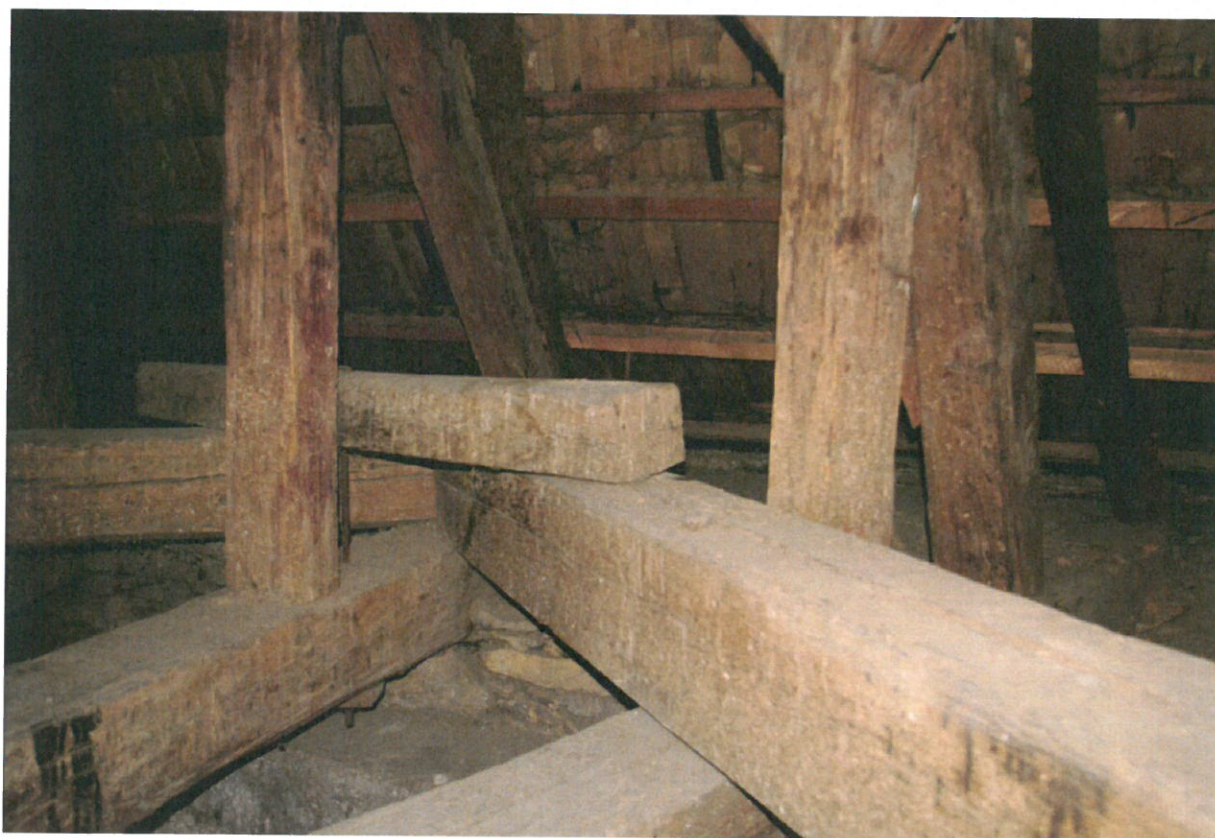
Obr. 25: Detailní pohled na konstrukci vyvěšující základový rošt (Kudrnovský 2014).
