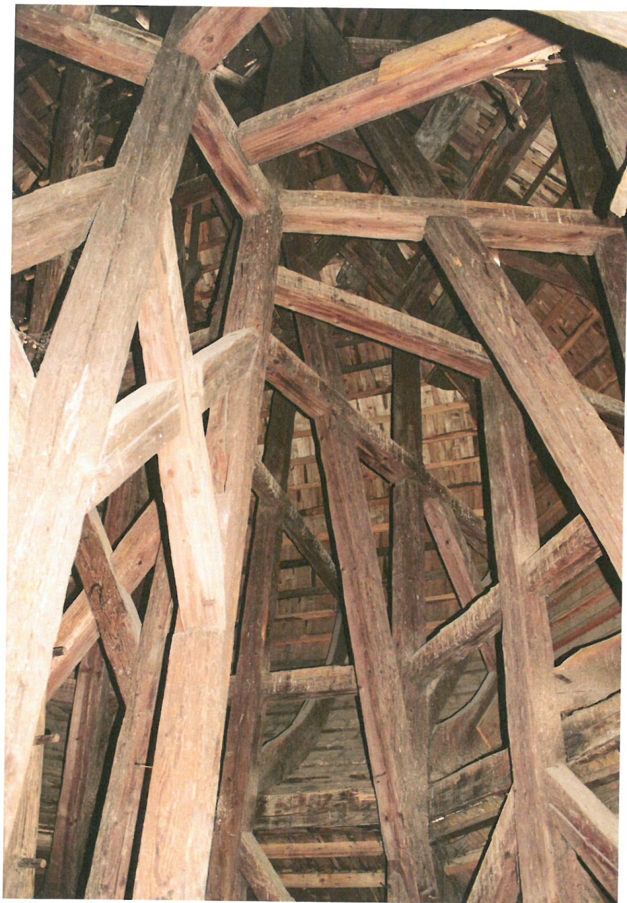
Obr. 15: Pohled na spodní část konstrukce cibulové střechy (Rohlíček 2014).
