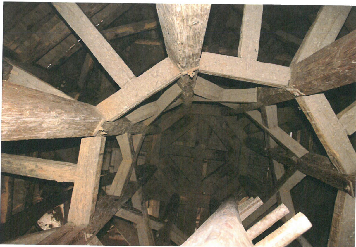
Obr. 16: Pohled středovým sloupem - štenýřem na základový rošt (Kudrnovský 2014).
