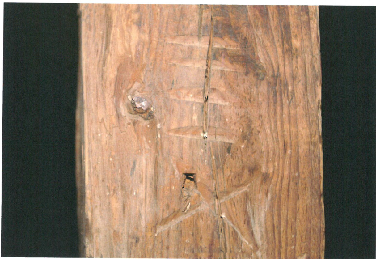
Obr. 23: Detailní pohled na tesařskou značku na sloupu štenýře (Kudrnovský 2014).
