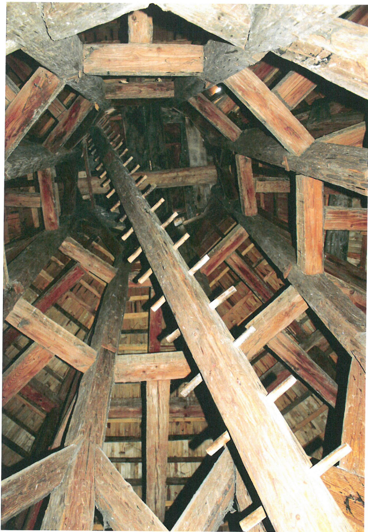
Obr. 12: Pohled středovým sloupem - štenýřem (Rohlíček 2014).
