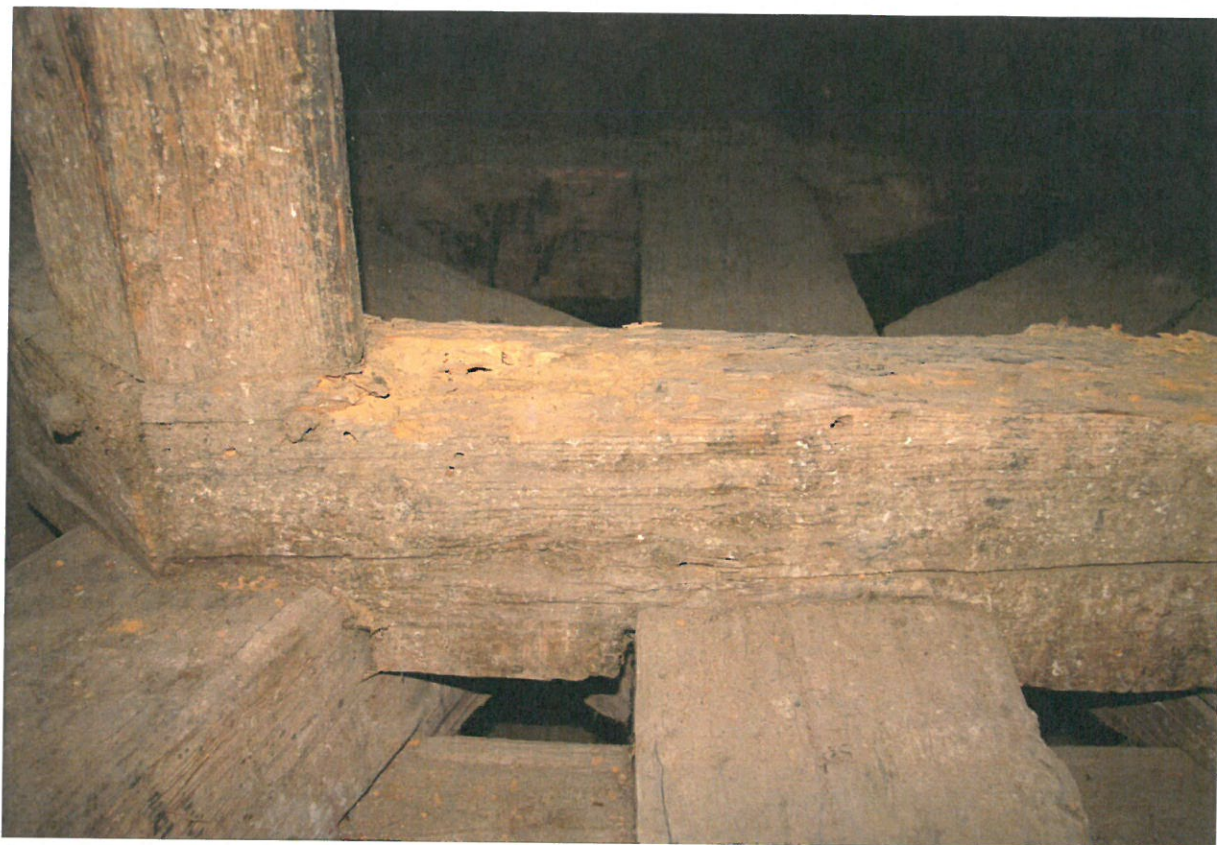
Obr. 20: Detailní pohled na bioticky napadený prvek osmibokého věnce středového sloupu kampovaného do základového roštu (Kudrnovský 2014).
