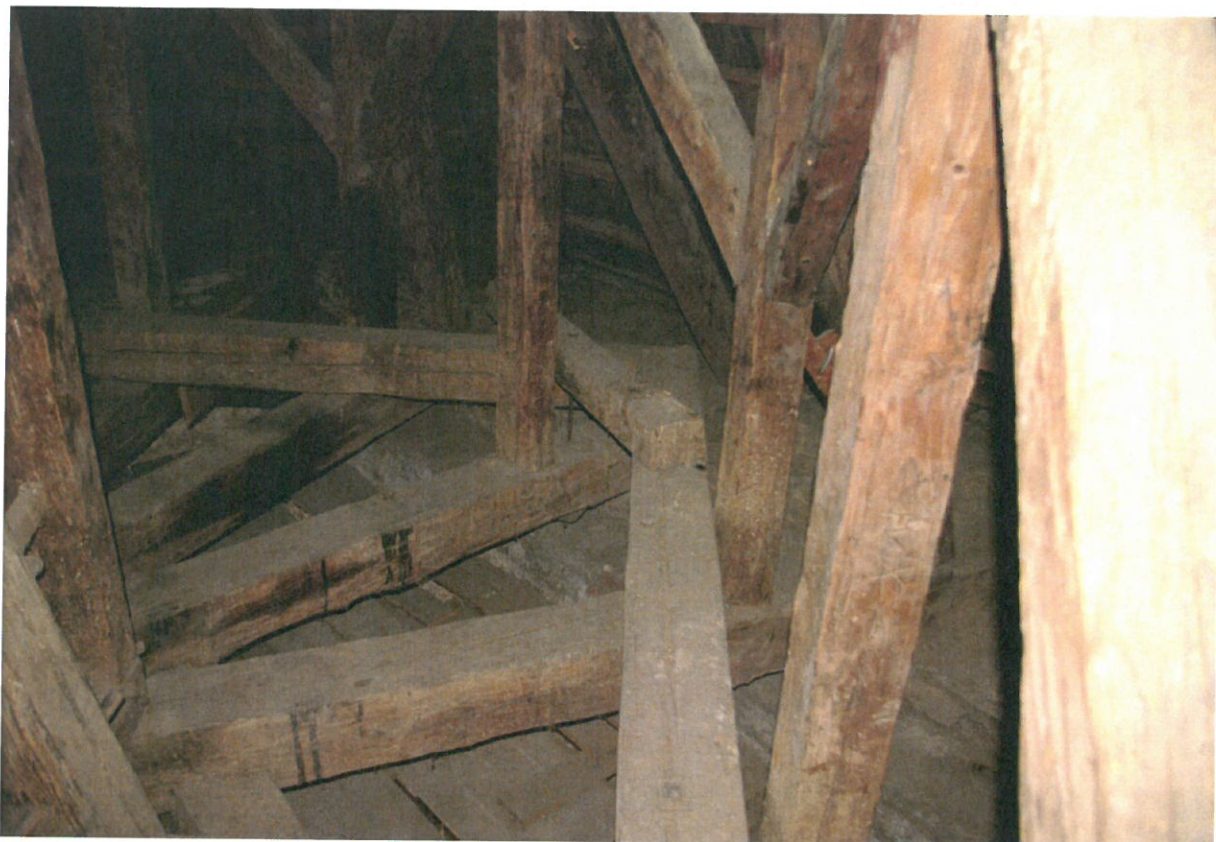
Obr. 24: Vyvěšení základového roštu (Kudrnovský 2014).
