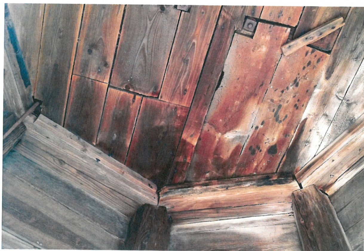
Obr. 40: Záklop horní cibulové stříšky (Rohlíček 2014).
