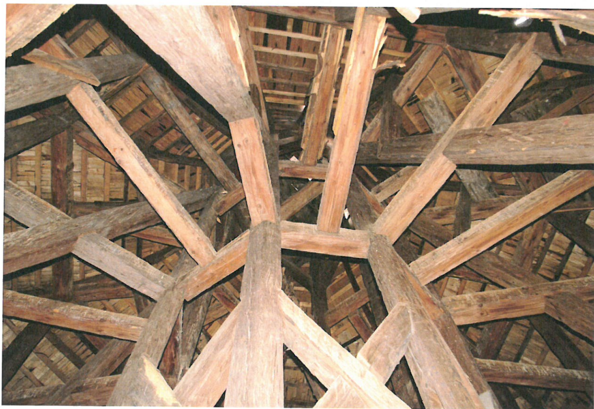
Obr. 14: Pohled na středový sloup s prvním a druhým hambalkovým patrem. Na prvcích obou pater je zřetelné jejich biotické napadení (Kudrnovský 2014).
