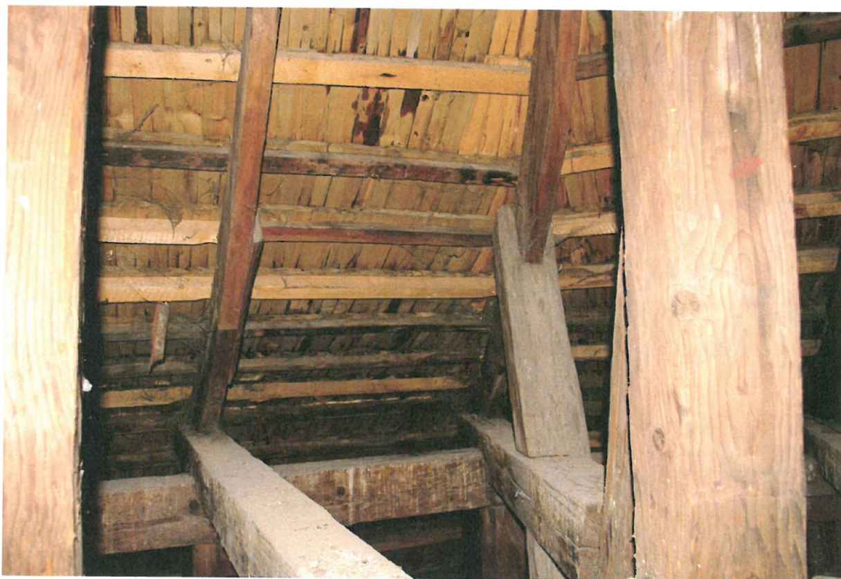
Obr. 34: Hambalek druhého patra kámpovaný do vaznice. V pavé části obrázku je viditelná šikmá vzpěra podporující ramenát (Kudrnovský 2014).
