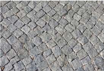
01 vozovka — žulová dlažba
