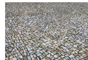
03 chodník — odseková dlažba
