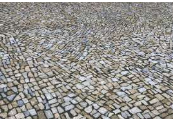
03 chodník — odsekovaná dlažba
