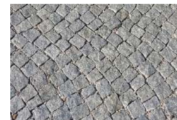
01 vozovka — žulová dlažba
