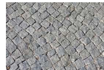
01 vozovka — žulová dlažba
