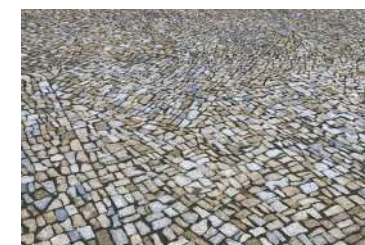
03 chodník — odsekovaná dlažba
